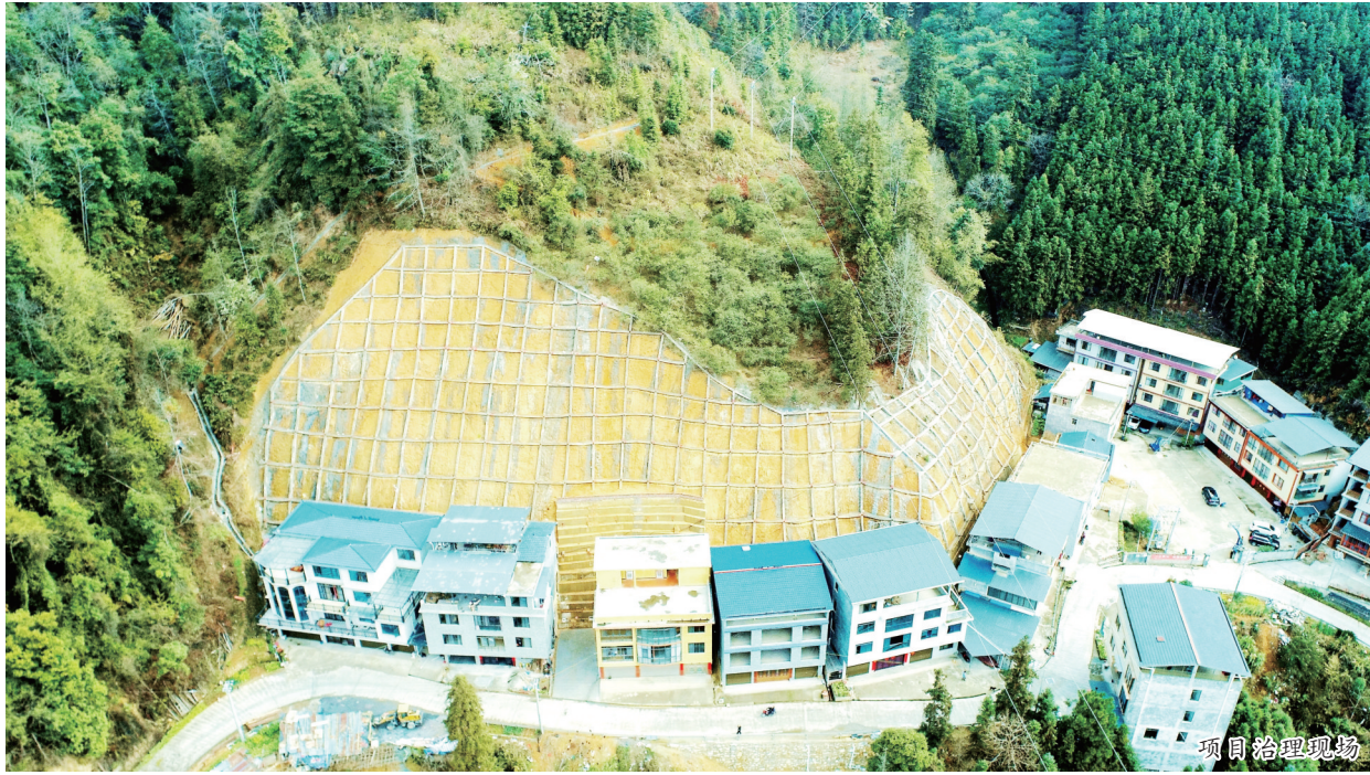
项目治理现场
